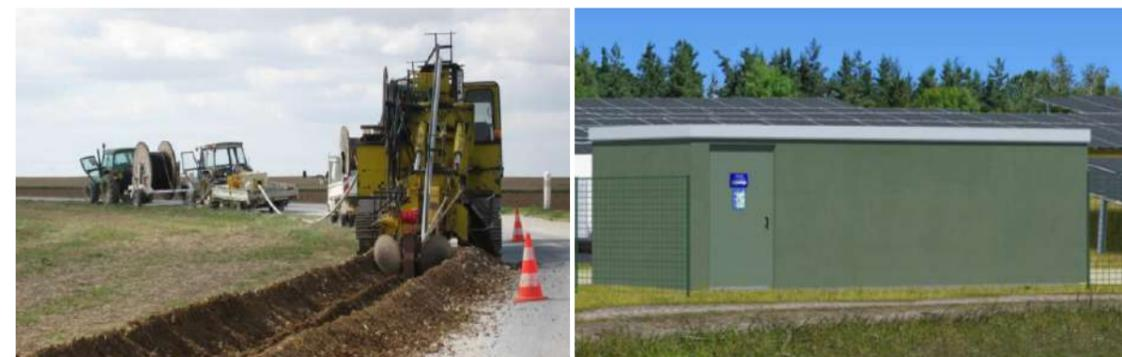
Photographie 7 : Déroulage et pose des câbles (à gauche), exemple de poste de livraison (à droite) (source : EDF RENEUVABLES)
