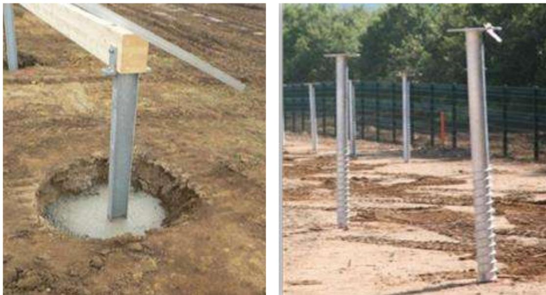
Photographie 5 : Fondation béton (à gauche) ; fondation vis (à droite)
