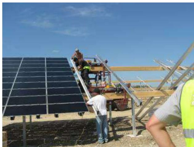
Photographie 6 : Montage de modules sur des supports fixes (à droite) (source : EDF RENEUVABLES)
