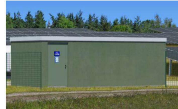
Figure 15 : Exemple d'un poste de livraison (Source : EDF Renouvelables)
